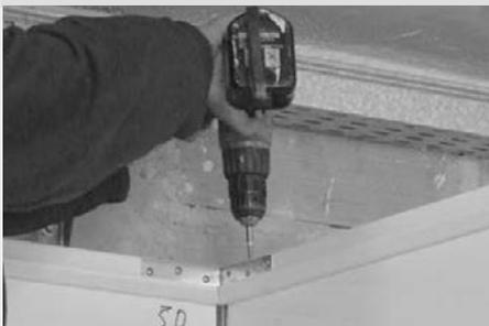
Al igual que el aro base, las cuatro piezas se suministran etiquetadas como "FACHADA, DERECHA, TRASERA e IZQUIERDA". Situado el aro superior en la posición correcta, se fijará a los módulos.
