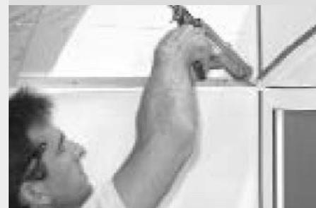
Una vez fijados todos los perfiles sellaremos sus uniones con silicona, tal como se indica en la fotografía de arriba.
