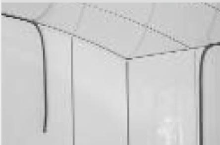
Una vez colocados los módulos del techo, centrados en todo su perímetro en los perfiles que lo soportan, colocaremos la junta de goma, con la que conseguiremos su fijación y estanqueidad.
