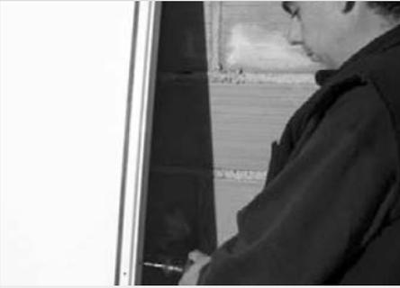
Los uniremos con una cantonera y los fijaremos mediante tornillos de 70 mm, tal como indica la figura.
