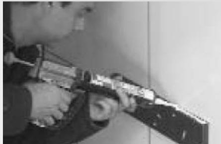
Antes de fijar los soportes de bancos colocaremos un cordón de silicona alrededor de los taladros de la pared. Seguidamente fijaremos el soporte con tornillos de 30 mm. Esto evitará que se produzcan ruidos al sentarse o levantarse del banco.
