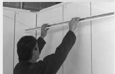
Una vez fijado el aro superior, colocaremos los perfiles que soportan los módulos del techo. Dichos perfiles están etiquetados de la misma manera que los aros superiores e inferiores: "DERECHA, IZQUIERDA, TRASERA Y FACHADA".
