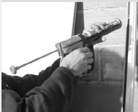
Las ánimas y las cantoneras siempre deben estar selladas con silicona, como bien puede observarse en la figura. Y así hasta cerrar íntegramente la cabina en sus cuatro paredes.
