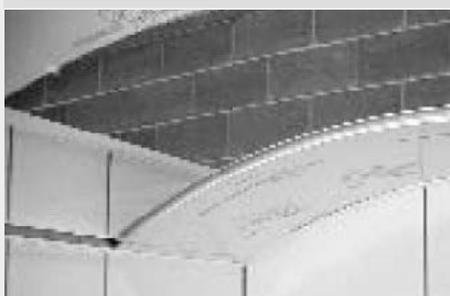
Una vez fijados los perfiles, se seleccionarán los módulos de techo premarcados con los textos "TECHO 1", "TECHO 2", etc.
