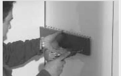
Colocaremos los soportes de banco en el lugar que les corresponde siguiendo las numeraciones, como bien indica la figura. Una vez colocados todos los soportes, procederemos a la colocación de los bancos. Estos están etiquetados con los nombres "NIVEL 1", "NIVEL 2", "NIVEL 2 derecha", etc.; dichas numeraciones las haremos coincidir con las del plano específico de esta cabina suministrado con el manual.
