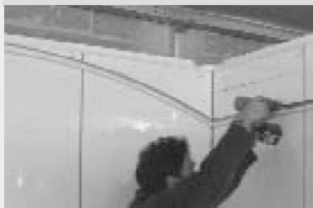
Primero colocaremos los perfiles rectos en el lugar que corresponda; posteriormente colocaremos los perfiles curvados. Estos serán fijados con los tornillos de 16 mm.
