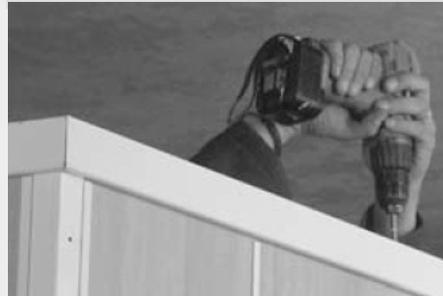
Esta fijación se realiza con los tornillos de 60 mm en posición vertical y en los agujeros repartidos en todo el perímetro del aro.
